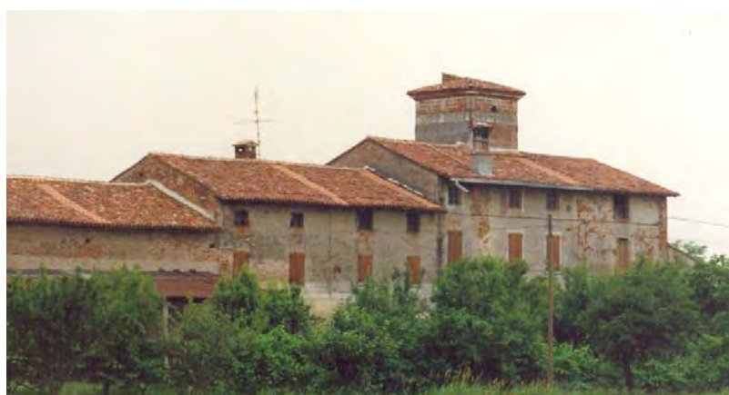
Fig.1: Le strisce chiare sui tetti indicano l'antica presenza di muri tagliafuoco. Il principio era quello di compartimentare le unità abitative in caso di incendio localizzato.
