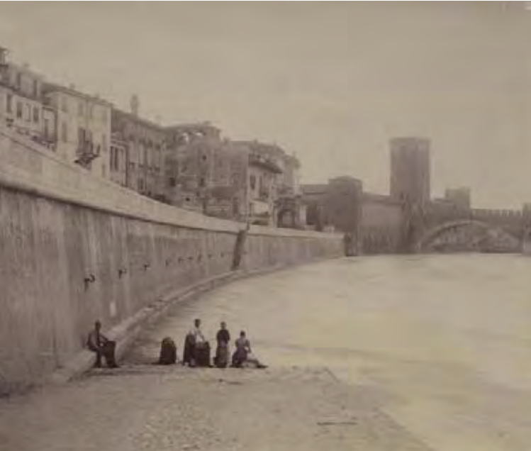
Attacco del muraglione destro a Castelvecchio
