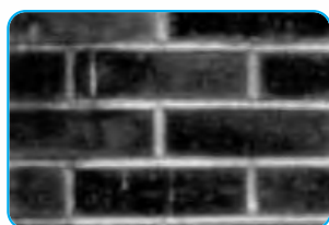
Macchie provocate da un pessimo lavaggio con acido cloridrico (muro non sufficientemente bagnato prima della pulitura, e non adeguatamente risciacquato dopo). L'acido ha corrosso il legante della parte superficiale dei giunti di malta, favorendo così il deposito di silicati sui mattoni.
