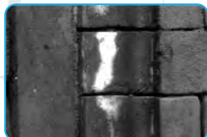
Macchie provocate da un pessimo lavaggio con acido cloridrico (muro non sufficientemente bagnato prima della pulitura, e non adeguatamente risciacquato dopo). L'acido ha corrosso il legante della parte superficiale dei giunti di malta, favorendo così il deposito di silicati sui mattoni.
